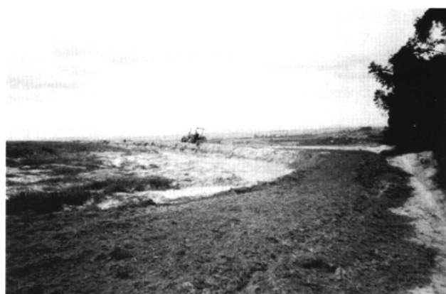
Figura 4 – Fazenda Taboca – realização do sistema de terraceamento
