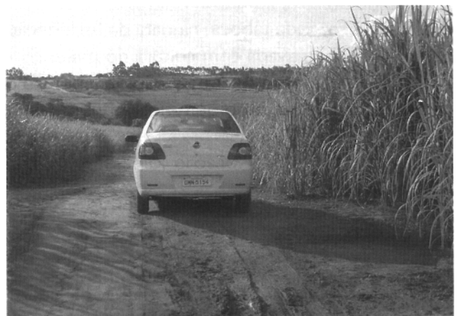
Figura 10 – Caminho adequado, com “camalhões” escoando águas pluviais aos “bigodes”.
