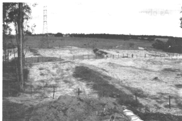
Figura 4 - Ao fundo, vista das duas bacias de contenção
