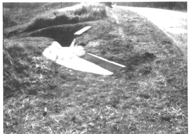
Figura 2 - Depois: saída de água da rodovia
