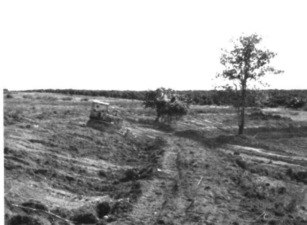
Voçoroca durante os serviços de recuperação
