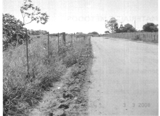
Foto 9 - Quebra do talude/revegetação da voçoroca
