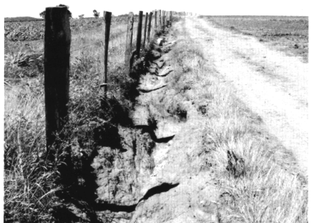
Figura 4 - Prado escoadouro construído de forma inadequada, com erosão em sulco
