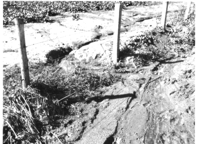
Figura 2 - Local onde as águas escoam, sob a cerca de divisa, para a propriedade vizinha
