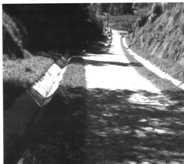
Foto 8 - Sarjetas e pista de rolamento em artefatos de concreto
