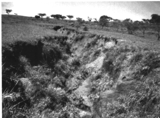
Voçoroca antes da execução dos serviços
