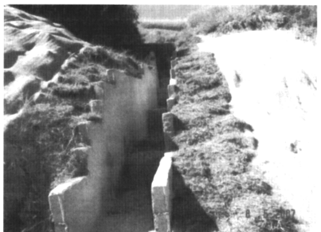
Figura 8 - Depois: escada hidráulica construída na faixa de domínio da rodovia SP-171
