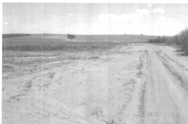
Foto 5 – Elevação do leito da estrada, com gradiente lateral, conduzindo as águas pluviais ao terraço
