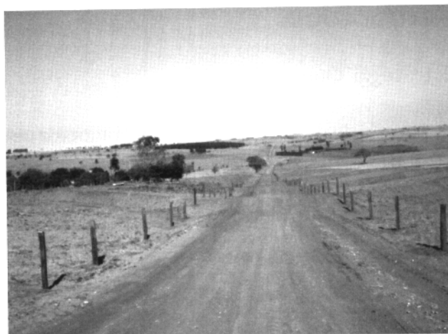
Foto 6 - Trabalho com elevação do greide e implantação de sistema de drenagens
