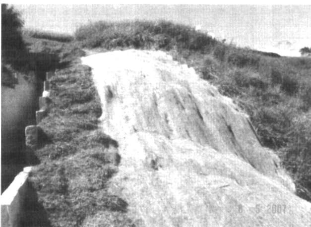
Figura 7 - Depois: manta de fibra de coco colocada para evitar a erosão na encosta
