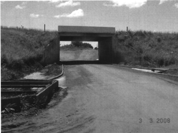
Foto 6 - Trevo de acesso na rodovia SP 284, às Thermas e ao perímetro urbano de Paraguaçu Paulista – “boca de lobo” captação das águas pluviais
