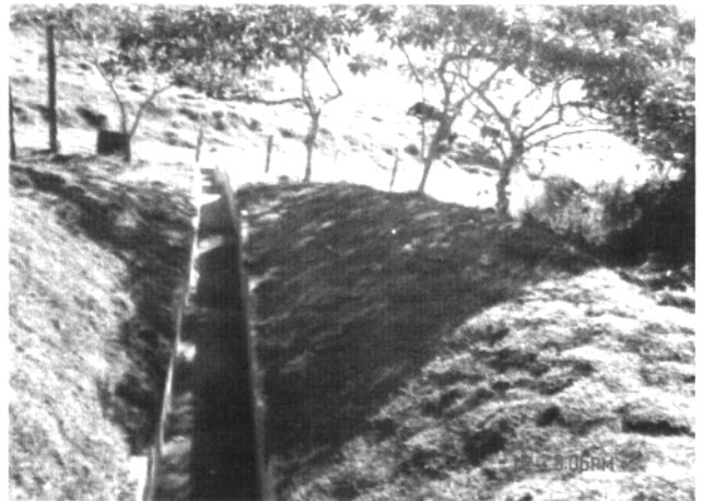
Figura 6 - Depois: dissipador de energia (escada hidráulica) construído na faixa de domínio da rodovia SP-171
