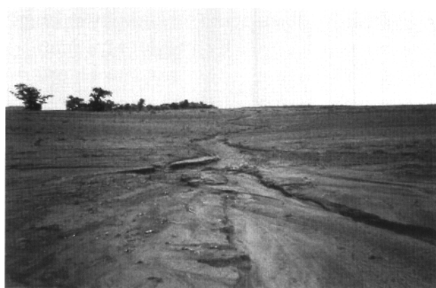
Figura 5 – Fazenda taboca, com erosão na data da fiscalização em 2002
