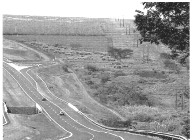
Figura 6 – Vista da área recuperada
