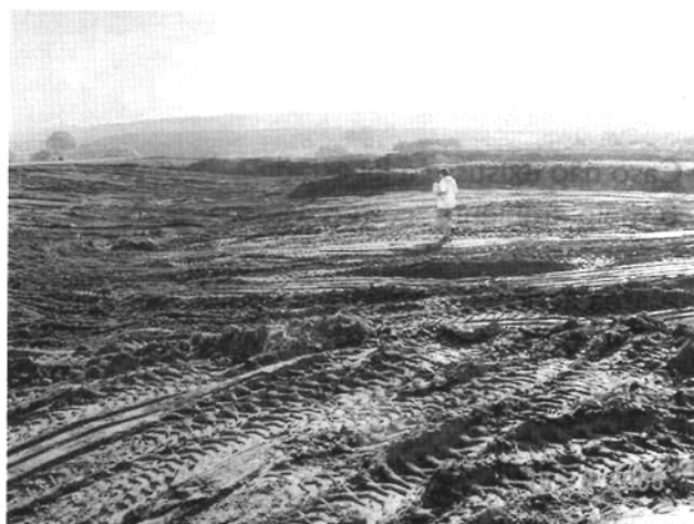
Figura 4 - Intervenção mecânica no antigo leito da erosão, finalização das obras mecânicas
