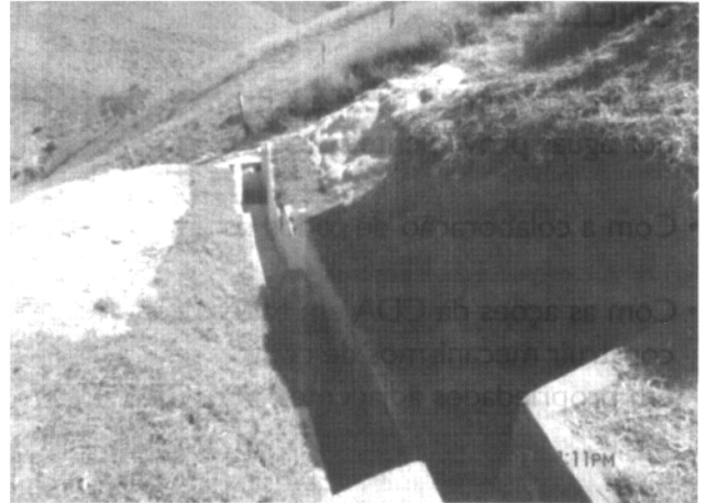
Figura 4 - Depois: dissipador de energia [escada hidráulica] construído na faixa de domínio da rodovia SP-171
