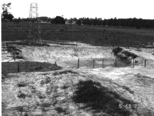
Figura 5 - Bacias de contenção construídas à jusante da SP 304
