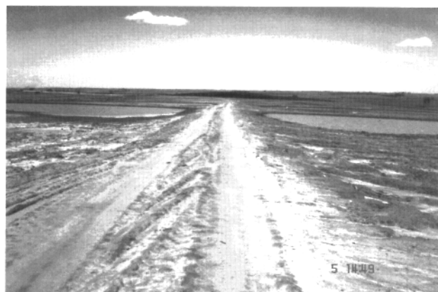
Foto 6 – Estrada adequada para o tráfego
