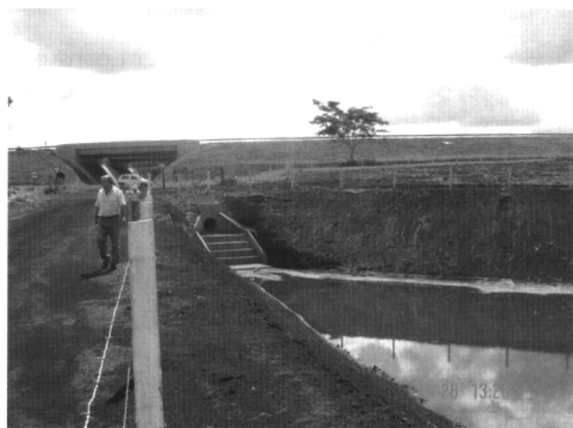
Figura 1 - Dissipador de energia - escada hidráulica construída na propriedade adjacente à rodovia SP 334 km 327,7
