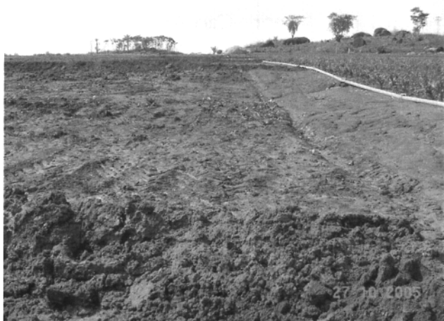
Figura 6 - Solo erodido na data da fiscalização em 2005
