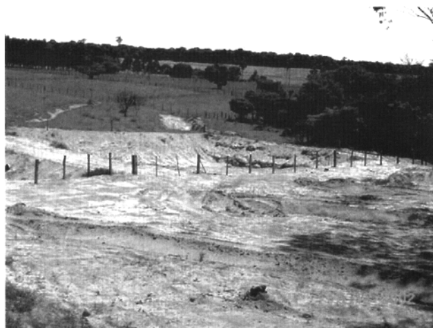
Figura 6 - Vista de bacia de contenção
