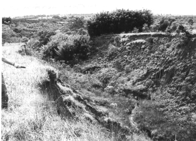
Figura 5 - Afloramento do lençol freático
