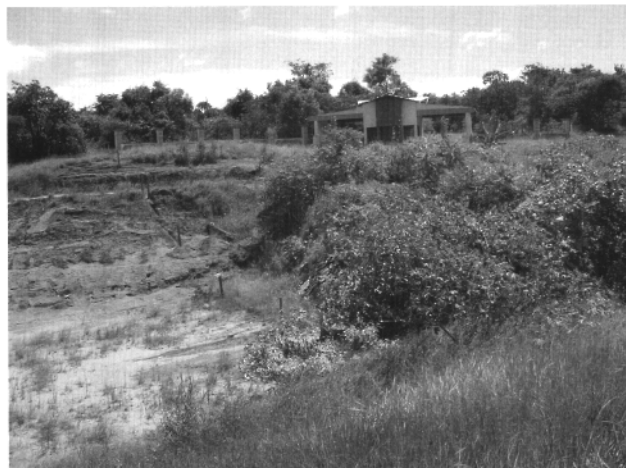
Foto 10 - Quebra do talude, caixas de contenção – passagem para APAE rural
