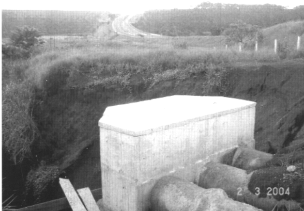
Figura 5 – Dissipador de energia
