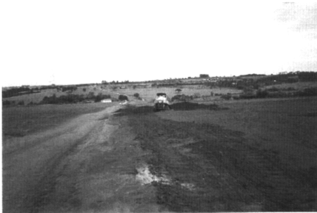
Figura 9 – Construção de “bigodes” nas margens do carreador
