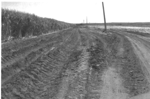
Foto 3 – Elevação do leito da estrada, sem acabamento
