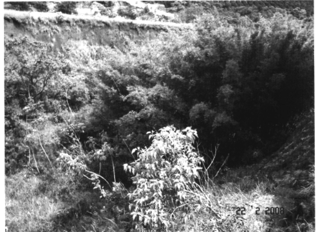
Figura 8 - Área de Preservação Permanente com vegetação, indicando a estabilização da erosão
