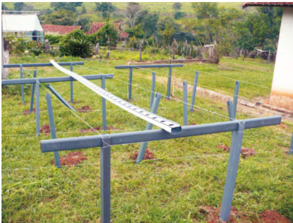
Figura 51 – Montagem de bancada de polipropileno – servem de suporte para os perfis.
