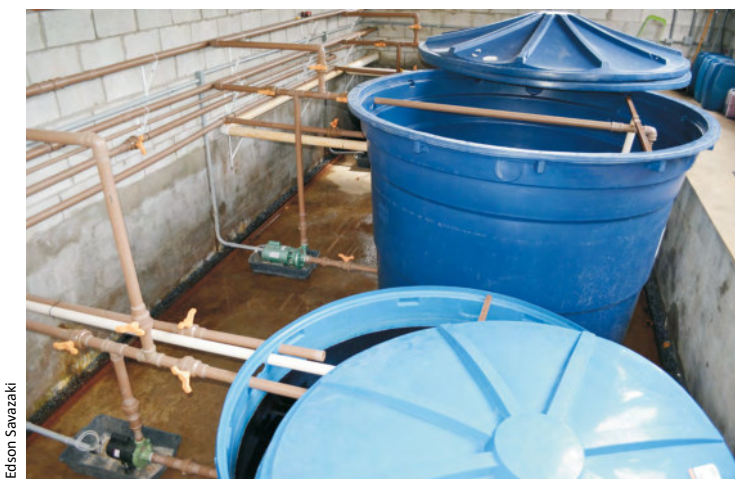
Figura 24 – Motobomba “afogada”
