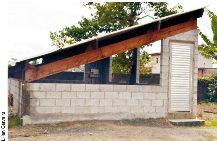
Figura 18 – Estrutura de proteção dos reservatórios
