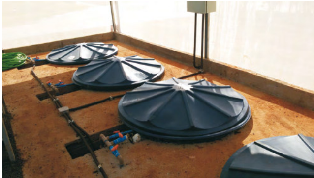
Figura 20 – Reservatório enterrado – proporciona isolamento térmico
