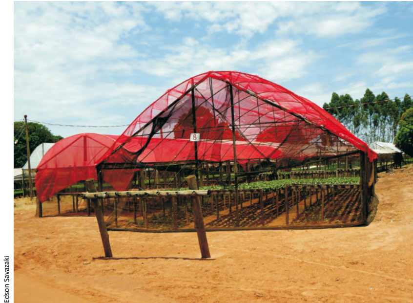
Figura 14 – Estufa modelo arco só com tela colorida para sombreamento (30% de sombra)
