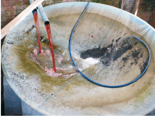
Figura 27 – Tela com função de filtro e proteção contra entrada de animais e sujeira
