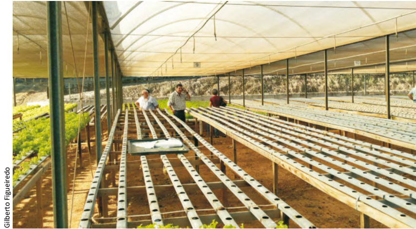
Figura 53 – Montagem da bancada com os perfis
