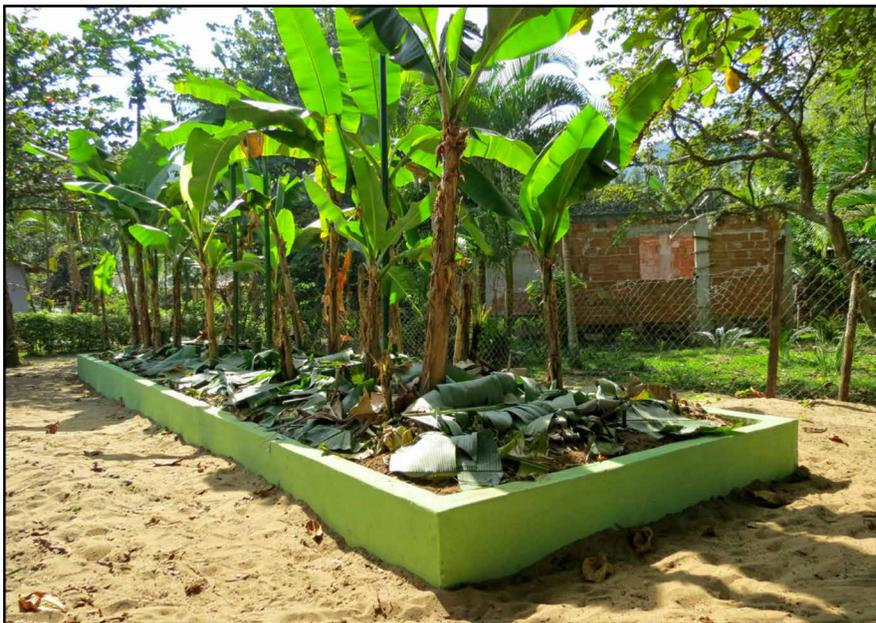
**Figura 11** – Bacia de evapotranspiração construída em comunidade caiçara de Paraty (RJ) pelo Projeto Observatório de Territórios Saudáveis e Sustentáveis da Bocaina.
