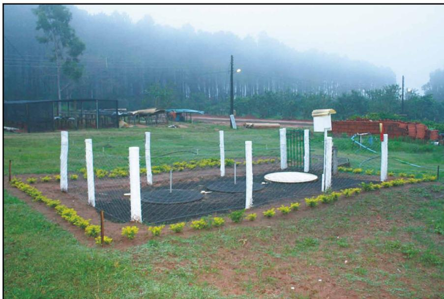
**Figura 3** – Fossa Séptica Biodigestora, com destaque para sistema de alívio de gases e cercamento, (SILVA et. al, 2017).
